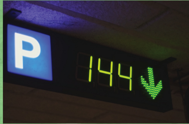
ใช้ระบบ Smart Parking ในการแจ้งปริมาณ ที่จอดรถเพื่อลดการใช้พลังงาน ในการวนหาที่จอด
